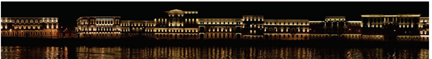
連続的にライトアップされたネヴァ川沿いの街並。その距離は約700mにも及ぶ。
